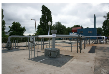
Exterieur de la centrale géothermique de Chelles
